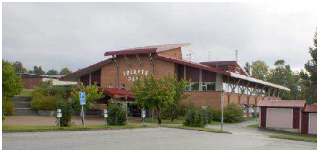
Bild på "Nya Folkets Park", byggd 1986.
