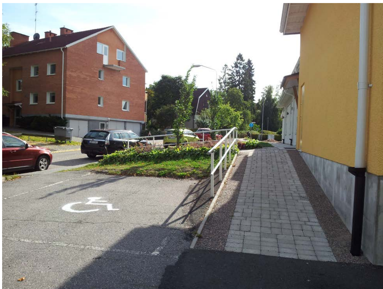
Tillgänglighetsanpassad entré till byggnaden på Kalkonen 8
