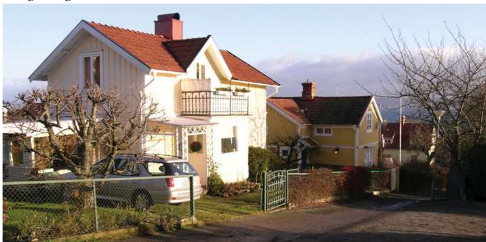
Figur 5 Byggnaderna på Tranan 11 och 12 sett från Krönleinstigen.
