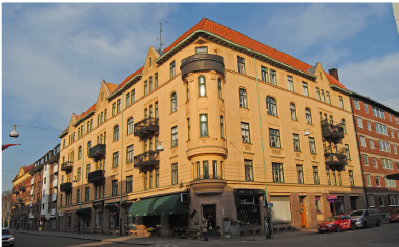
Bild 16. På bilden syns tak av enkupigt rött lertegel och takfoten klädd i grön plåt.
