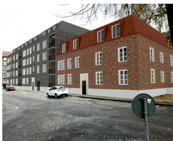
Bild 13. Ny byggnad i kvarteret från väst.
