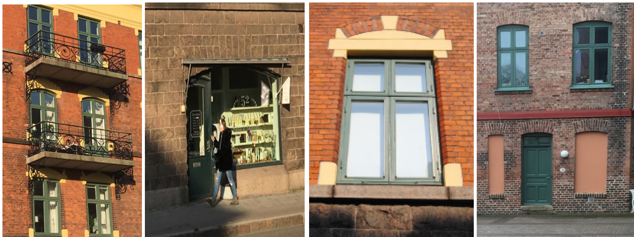
Bild 17-20. Bilderna visar utskjutande balkonger, skyltfönster, butiksentré, befintliga fönster och originaldörr mot innergård.
