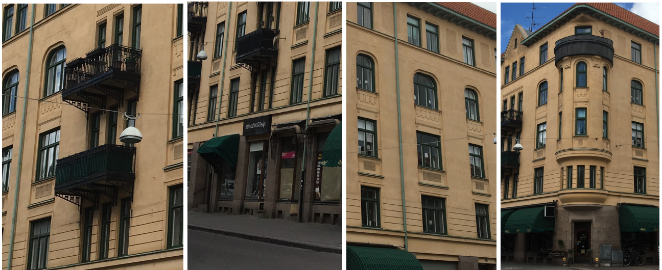
Bild 21-24. På bilderna syns utskjutande smidesbalkonger, skyltfönster, butiksdörrar, befintliga fönster och originalfönster i runt burspråk.
