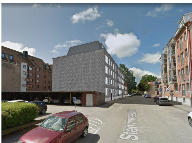
Bild 12. Ny byggnad i kvarteret från öst.
