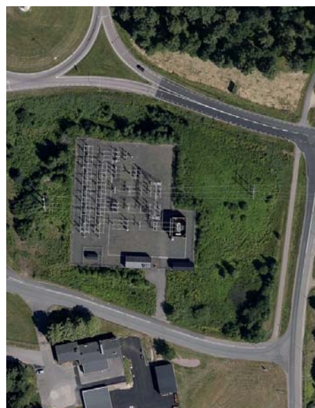
Vattenfalls transformatorstation och luftburna högspänningskablar
