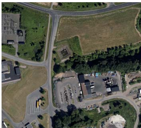
Risängens återvinningsanläggning som gränsar till planområdet
