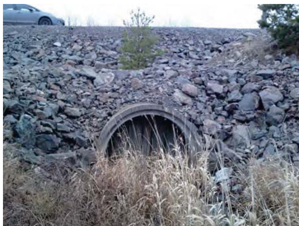
Figur 24. Kulvert för Prästgårdsån genom befintlig banvall, vid km 56+435.
