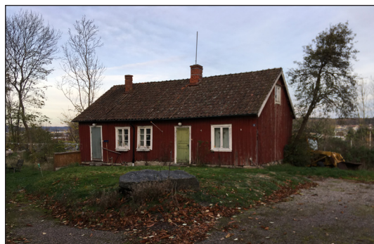
Tillhörande bostadsbyggnad värderad som klass C.
