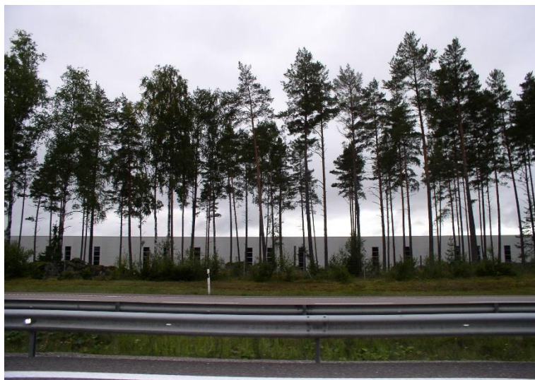
Verksamhet och sparad vegetation på södra sidan av E18
