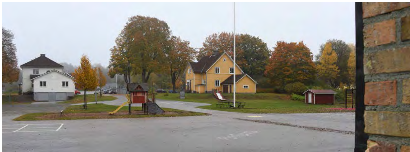
Bild över delar av skolgården med det före detta kommunhuset, gula villan och i förgrunden en detalj av tegelmurverket med de gröna fogarna hos den yngsta skolbyggnaden.
