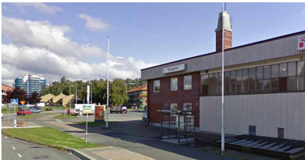
Bild från Hovdalavägen norrut. Infarten till macken syns innan rondellen. Framför byggnaden i förgrunden finns en bussbäddplats för stadsbussar.
