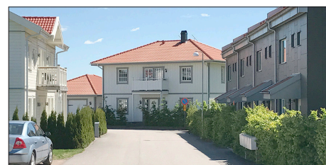
Häcken längs gatorna förstärker gränsen mot den privata tomten och stöttar gatan. Kabblagårdsgatan etapp 1.
