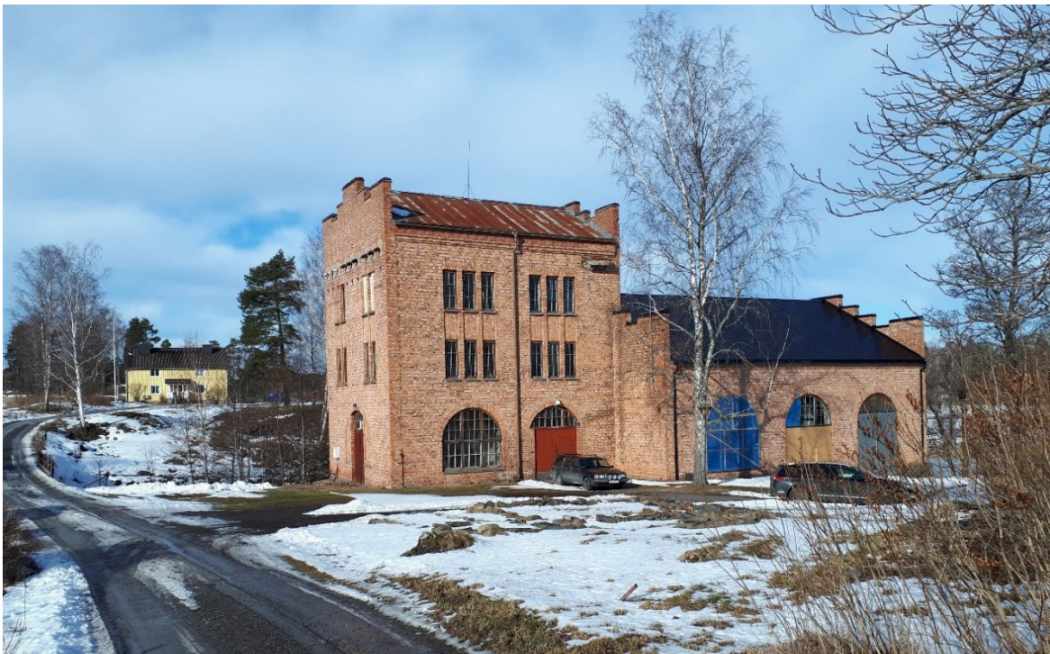
Fors kraftstation sett från öster
