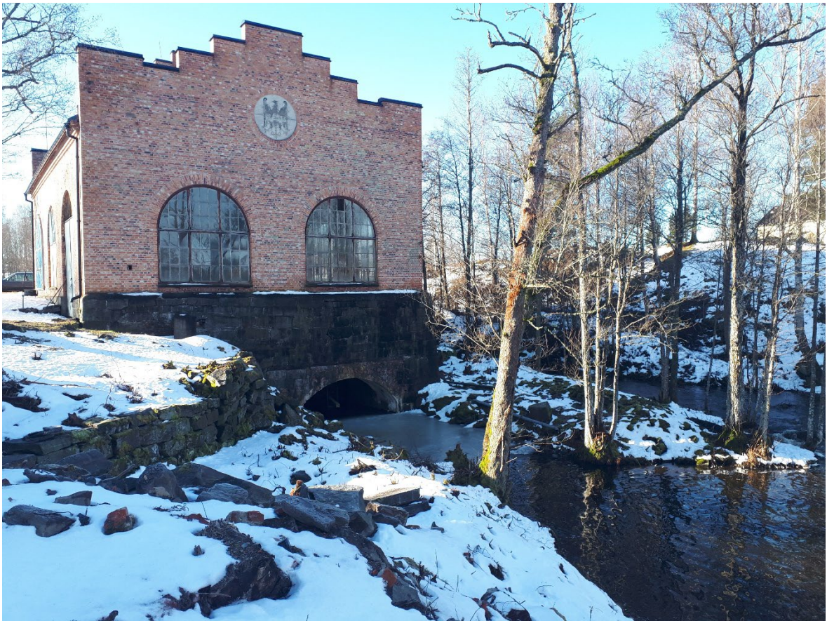
Kraftstationens norra fasad med Billeruds emblem och den krenelerade gaveln
