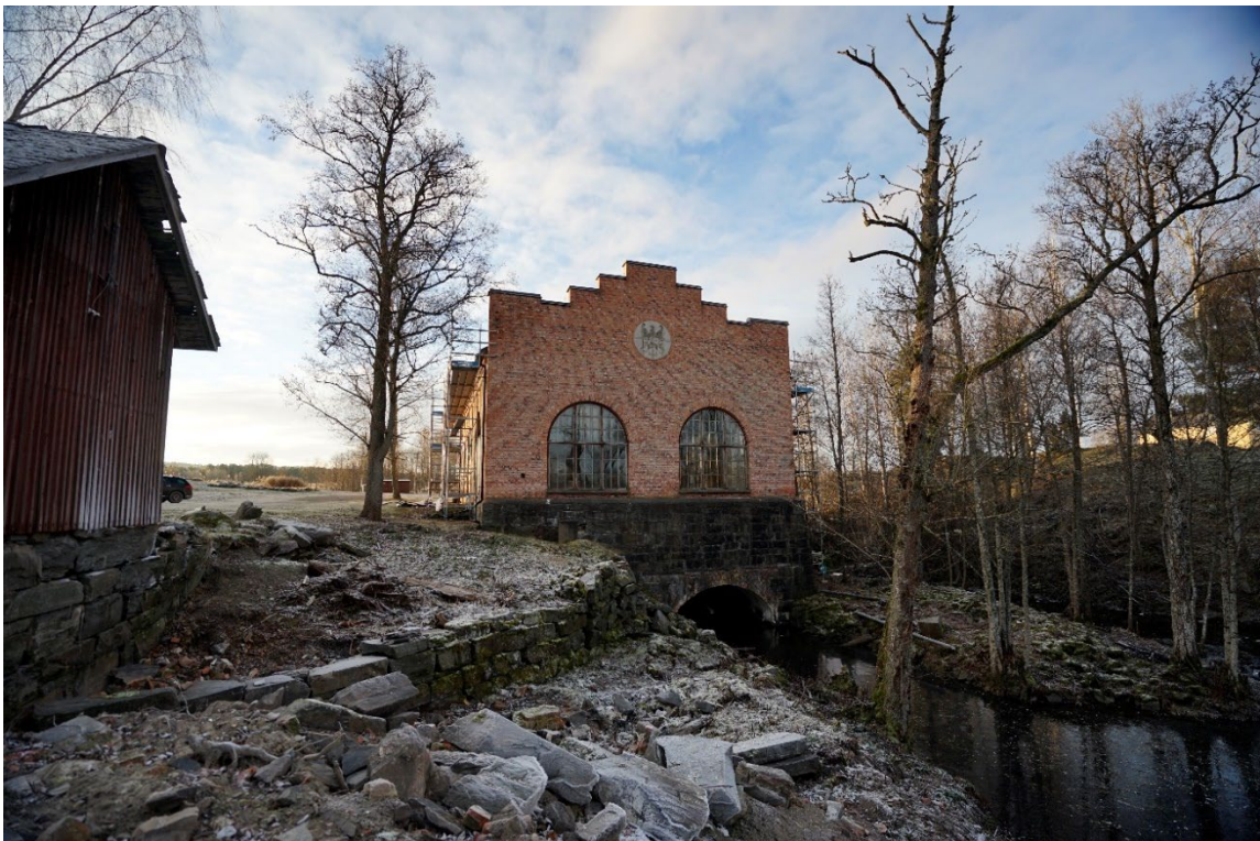
Den modifierade strandlinjen (se utloppet nere till höger av fundamentet)
