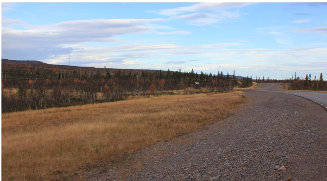
Figur 25. Vy mot norr mot planområdets östra delar. Bild är tagen från Nikkaluoktavägen, strax norr om den plats där vägen går över järnvägen till Kiruna. Denna del av planområdet är det som i huvudsak syns vid färd söderut längs Nikkaluoktavägen.
