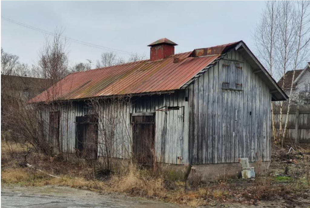
Befintlig uthusbyggnad i södra delen av Bromsen 10
