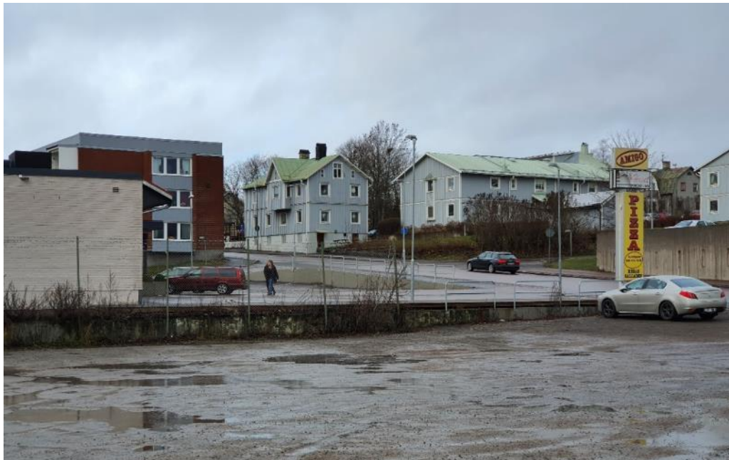
Stående vatten på västra delen av Bromsen 10
