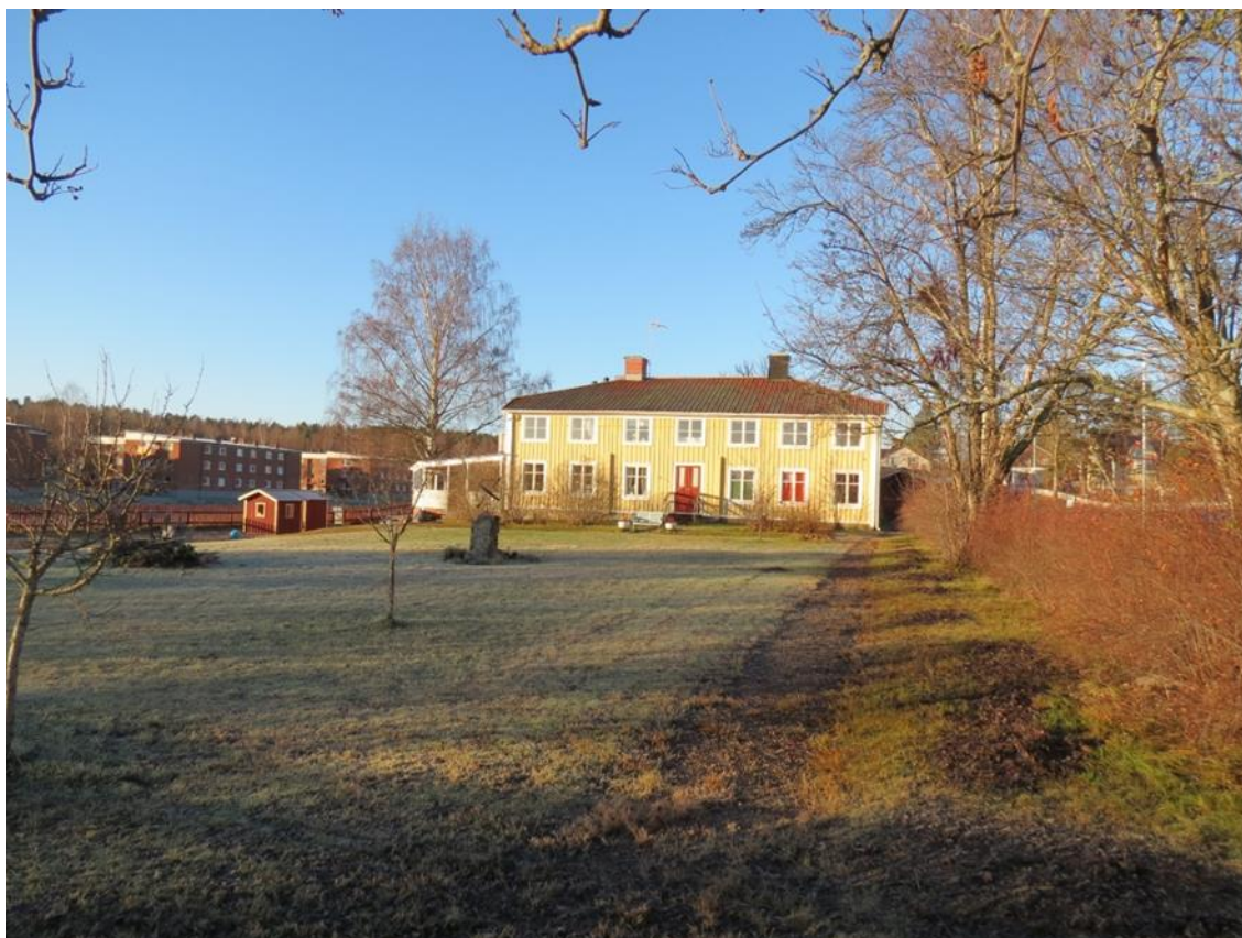
Gråsiskan 9 fasad från öst
