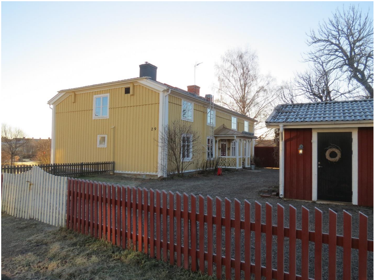
Gråsiskan 9 och förråd från norr
