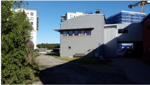
Byggnad 28 är den senast tillkomna byggnaden inom planområdet (rivs)
