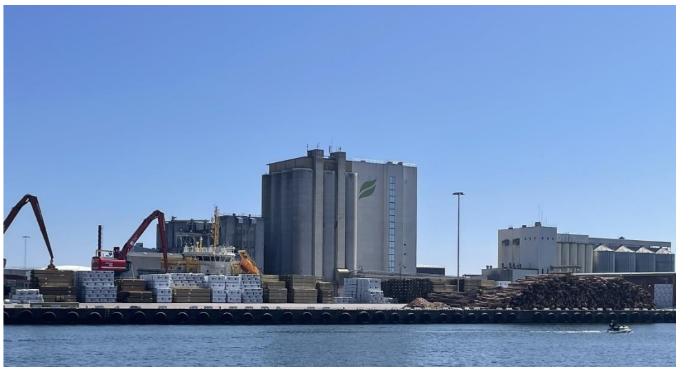
Bild 10. Silos, Swedish Agro
