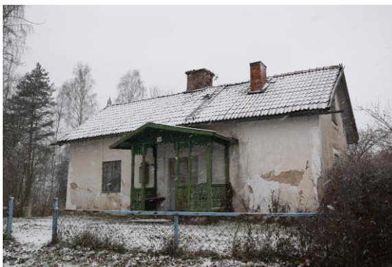
Det västra torpet (torp 1) som planeras att rivas.
