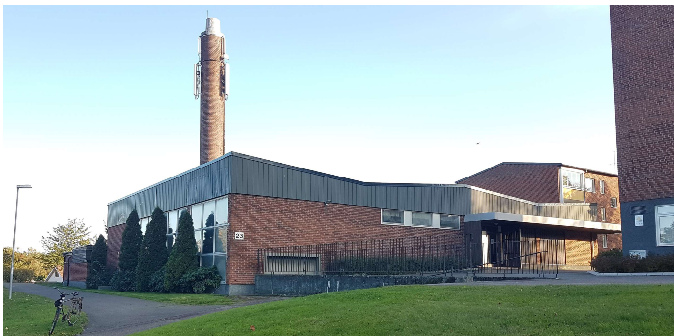
Panncentralen med sitt assymetriska tak och sin höga skorsten, bilden är tagen från nordväst.
