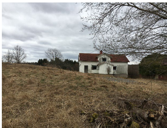
Figur 20 Befintlig bebyggelse, vy mot söder.
