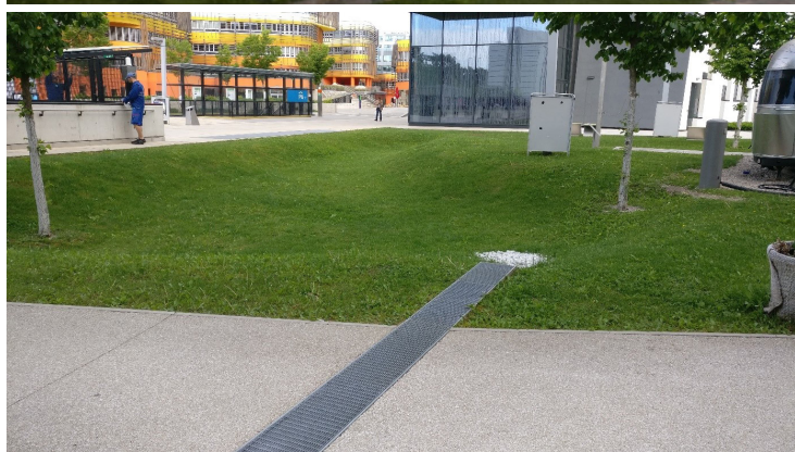
Inspirationsbild från Wien, enkelt system utan rör och brunnar direkt till en nedsänkt grönyta. Foto : Peter Engström
