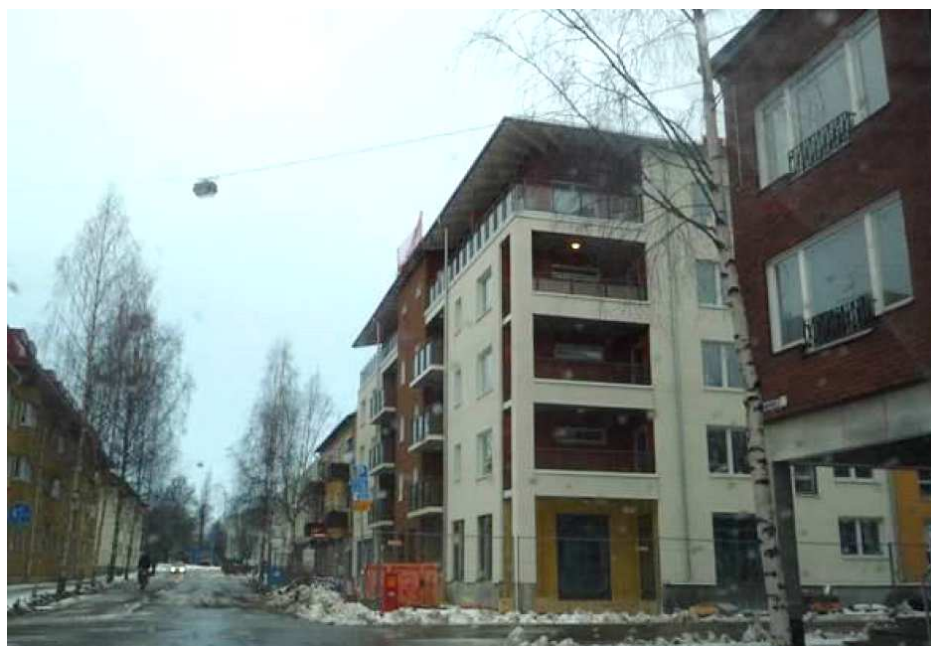
Kvarteret Vaktposten i Umeå. Ett exempel på nyproduktion i stadsmiljö. Balkongerna är integrerade med fasad samt med en utskjutande del motsvarande takutsprång.
