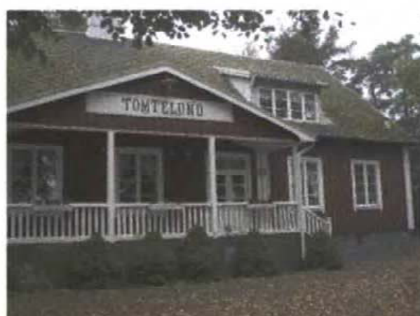
Tunneberga 1:28. Fasad mot öster, 2007-09-14.
