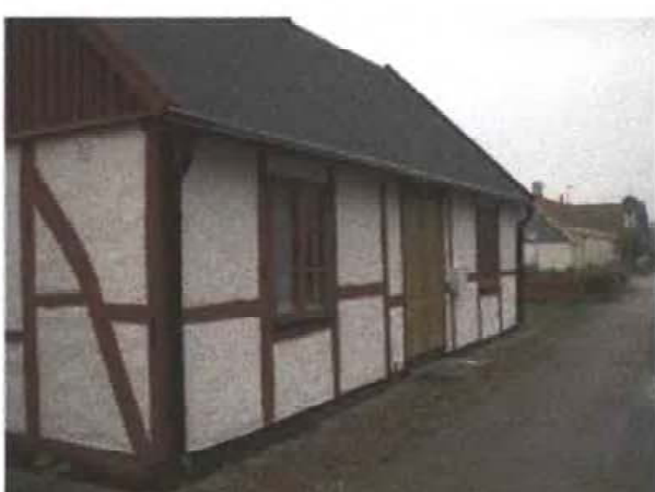
Tunneberga 2:23. Fasad utmed Jonstorpssvägen, 2007-09-14.
