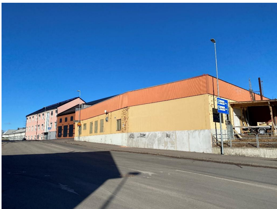
Befintlig verksamhetsbyggnad inom planområdet. Byggnaden är sammanbyggd med den bruna och rosa byggnaden i bakgrunden som rymts inom fastighet Torrdockan 1.
