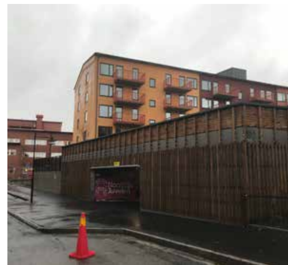
BEFINTLIGT BOSTADSGARAGE SOM SKAPAR OTRYGGA STRÅK
