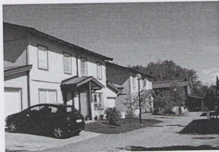
Befintlig bebyggelse söder om planområdet på Gårdsvägen
