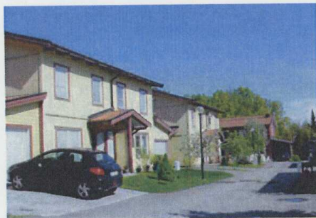
Befintlig bebyggelse söder om planområdet på Gårdsvägen
