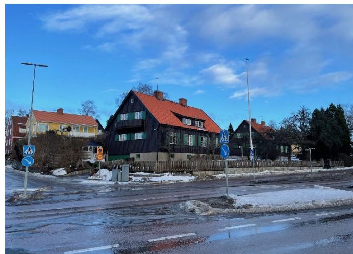
Figur 15: Äldre bebyggelse längs med Köpingsvägen på fastigheten Josefina 8. Byggnaden ligger norr om planområdet på andra sidan Köpingsvägen, cirka 30 meter från planområdet. Byggår cirka 1920.
