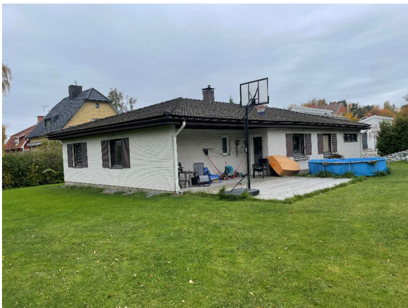
Figur 19: Befintlig byggnad på fastigheten Hagadal 1. Byggår 1975.
