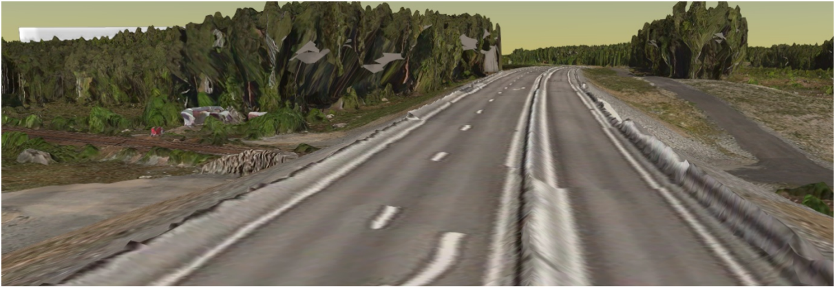
Vy från väg 52/55, planområdet sett från sydost.
