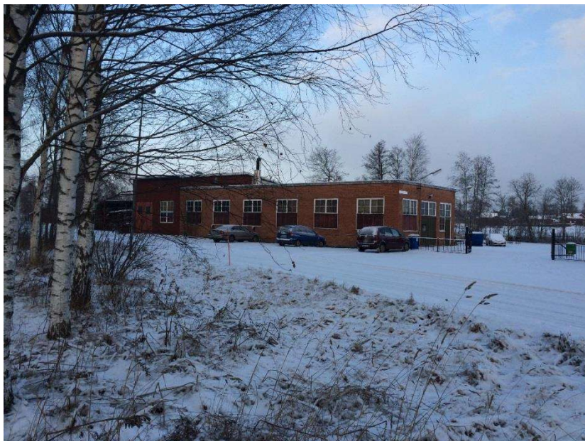
Bilden visar en av de intilliggande industribyggnaderna (Wetterlings) strax norr om planområdet.
