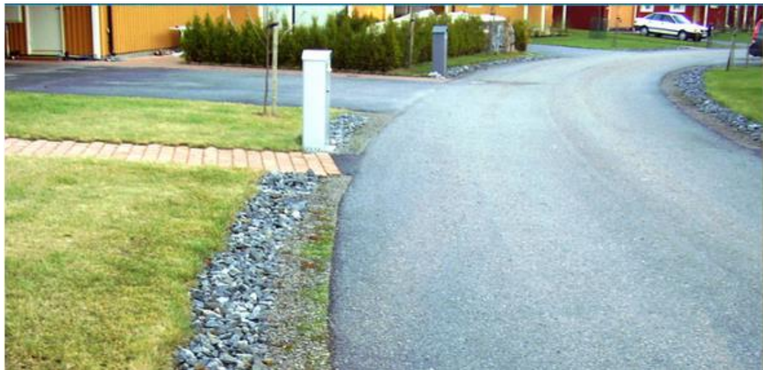
Figur 11. Förslag på makadamdike Bild från Stockholm vatten.
