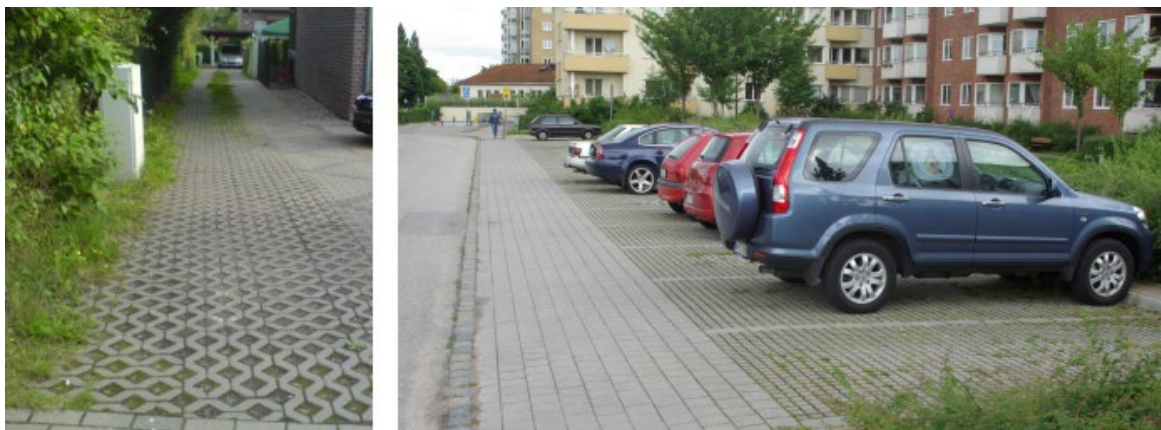
Figur 25. Exempel på genomsläpplig beläggning. Bild: Stockholm Vatten och Avfall.
