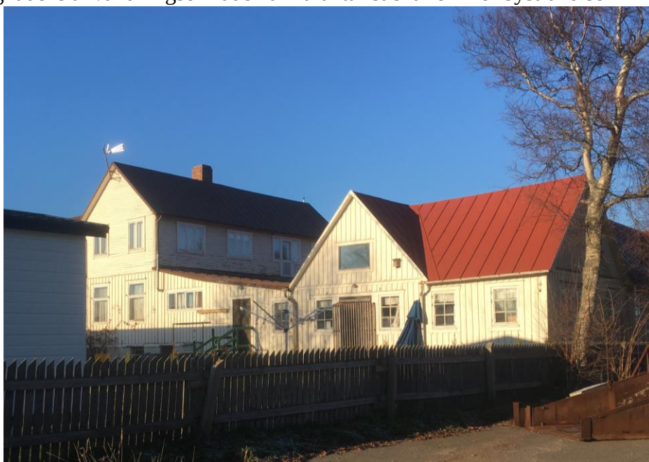
Den före detta barnkolonin, Kirunakolonin, sett från sydost.
