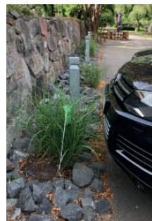
Bild 22 Infiltration intill parkering.
