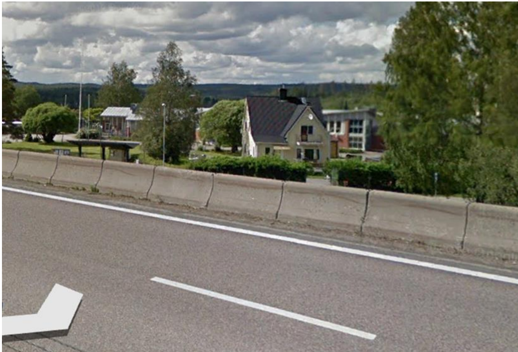
Figur 13. Tät betongbarriär som fungerar som avåkningsskydd samtidigt som brandfarlig vätska ej kan rinna igenom.
