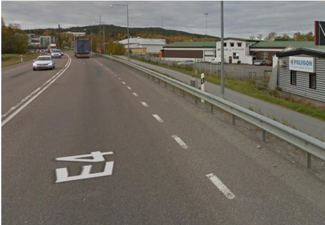
Figur 1. Befintligt avåkningsräcke vid aktuellt planområde.
