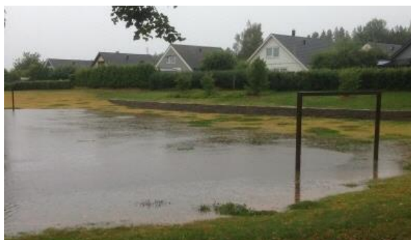
Fotbollsplan som utformats som utjämningsmagasin. Övre bilden visar planen, undre bilden visar planen när den är översvämmad, copyright Växjö kommun.
