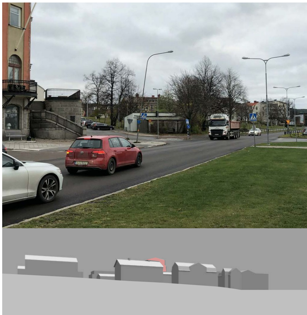
#2 Ovan: Foto från korsningen Strandgatan/Hotellgatan. Nedan: Volymstudie. Vy från korsningen Strandgatan/Hotellgatan. Röd byggnad illustrerar fullt nyttjad byggrätt.
