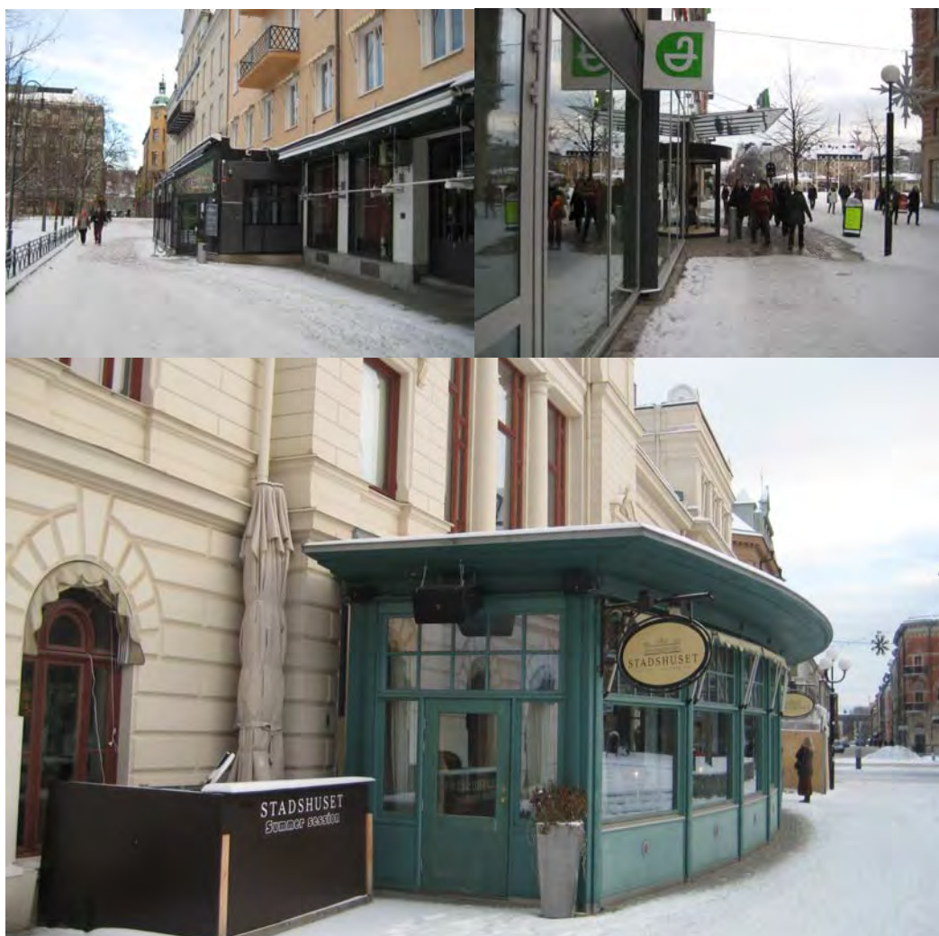
Exempel på existerande tillbyggnader i Stenstaden.
