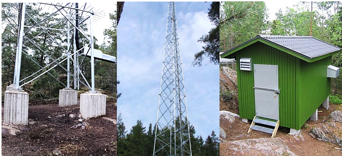
Bild till vänster visar exempel på mastfundament. Bild i mitten visar mobilmast i den masttyp som avses att uppföras. Bild till höger visar utformning av teknikbodar som verksamhetsutövaren avser att uppföra. (bildkälla: Hi3G)
