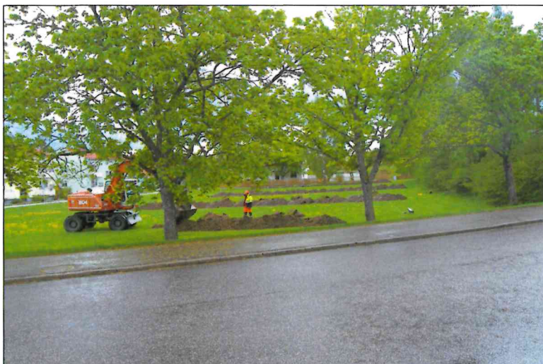
Figur 3. Översiktspild över schakten som grävdes inom ytan som planeras för bostäder. Bilden är tagen från nordväst. Foto: Ingeborg Svensson 2011, Sörmlands museum.
