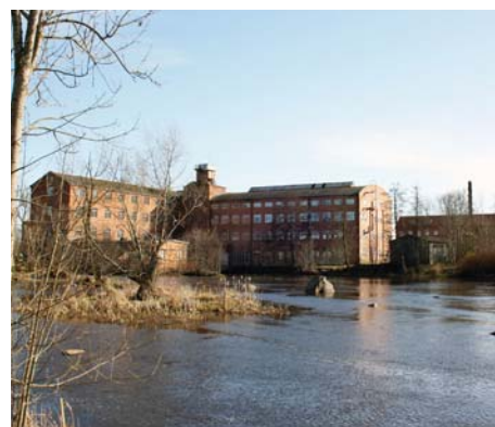
Den f.d. Yllefabriken vid ån Tidans. En del av Tidans kulturhistoriska byggnader.
