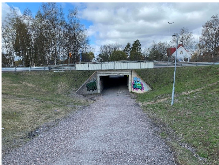
Vy från öster. Befintlig gc-tunnel mellan Linvägen och ICA-Bommen.
