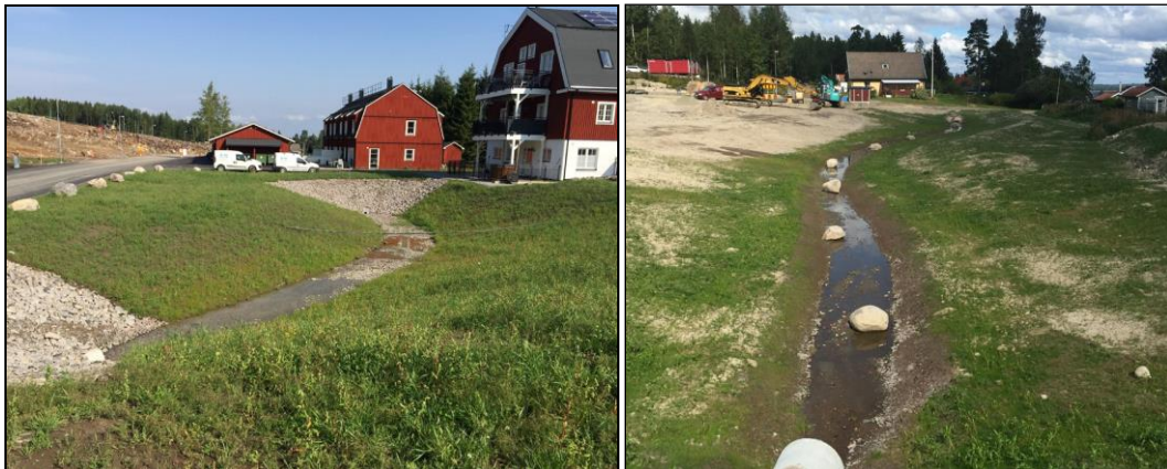
Exempel på öppna dagvattenmagasin med fördröjande effekt
