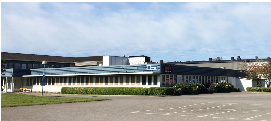
Intillgiggande kontorsbyggnad mot Göteborgsvägen där Securitas har kontor. Bakom byggnaden skymtar Erikshjälpens second-handbutik. Foto: Ann-Louise Hultér
