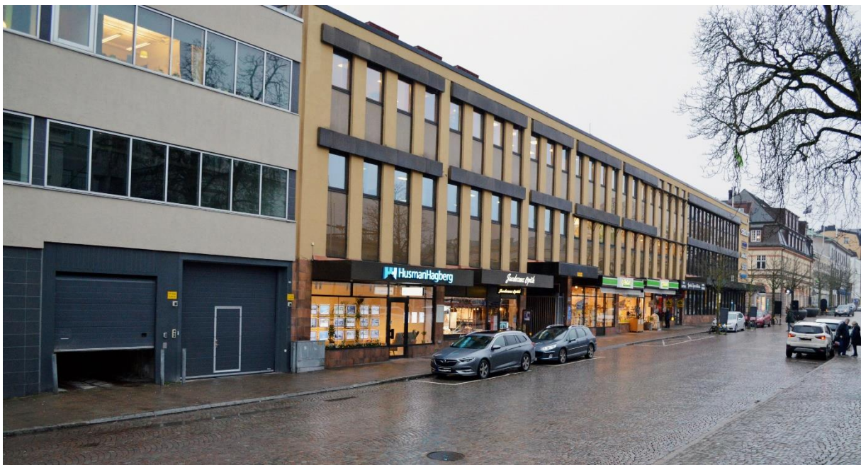
Kungsgatan januari 2020. Från denna vy syns inte skärmtaket alls. Foto: Samuel Palmblad
