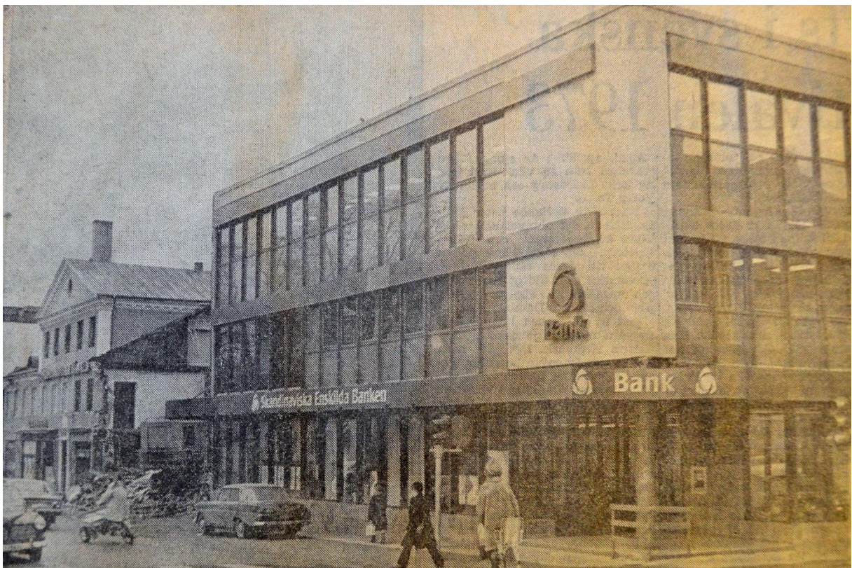
Smålandsposten den 10 februari 1973. Etapp I (hörnhuset) är färdigt och rivningen har just inletts för etapp II, bakdelen på grävsloppet anas mellan huskropparna. Smålands museums klipparkiv
