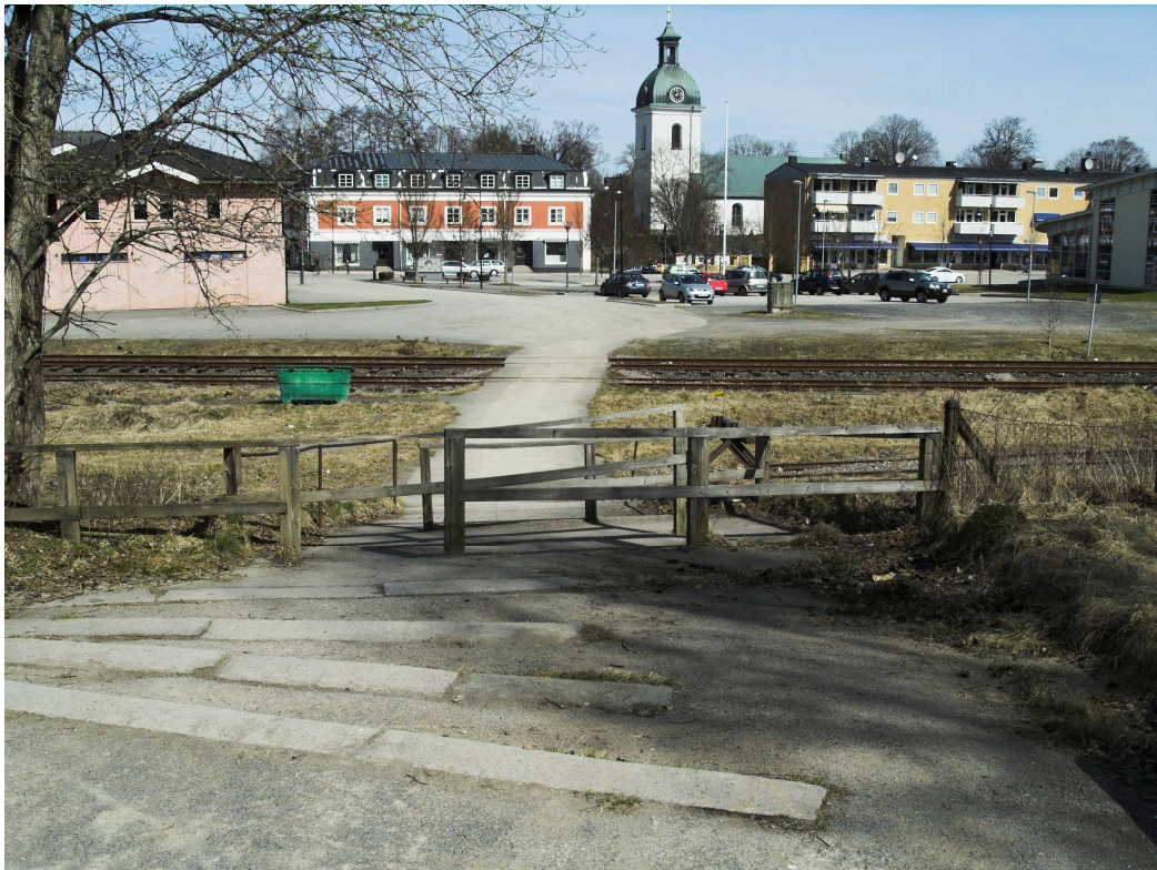
Utsikt från söder mot Sillakrökstorget. Trappa i Kexalid och övergång för fotgängare över järnvägsspåren i förgrunden.
