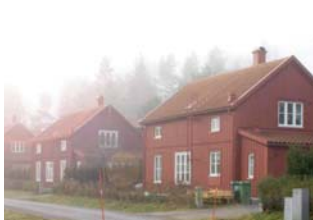
Karaktär på byggnad - Skogsbyvilla 1
