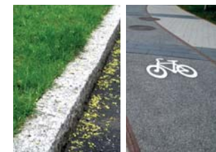
Kantstöd längs körbana Cykelväg på asfalt
