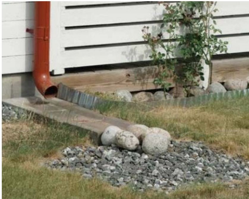
Figur 38. Exempel på utkastare som leds mot planteringsytor och stenkista.
