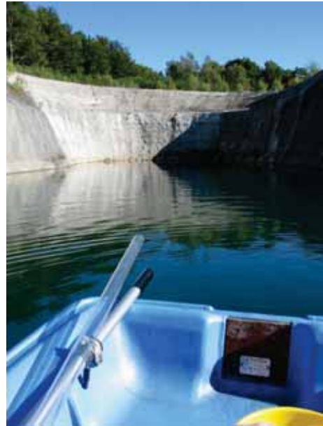
Mynningen på arbetstunneln vid Mellanpåslaget i september 2005 i samband med vattenprovtagning.
