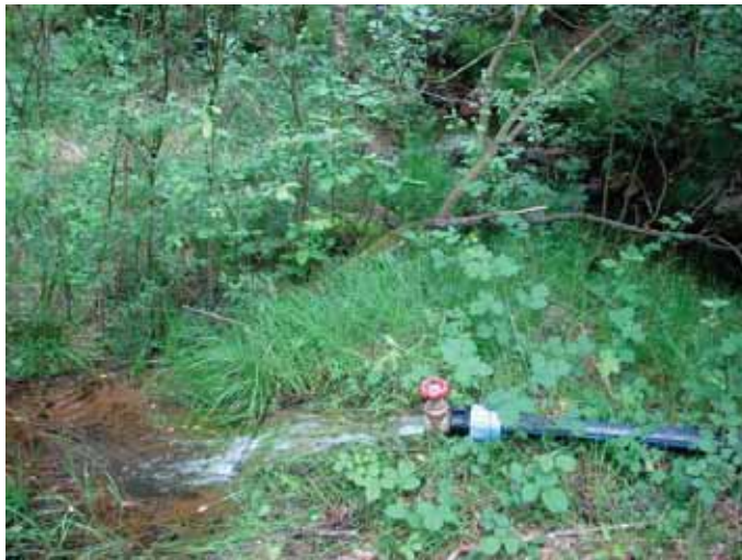
Utlledning av vatten som skyddsåtgärd till Böskestorpsbäcken i juni 2011.
