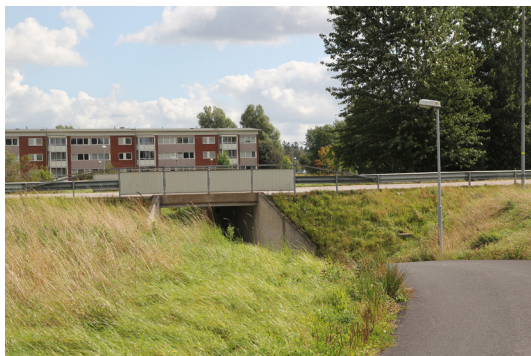
GC-tunnel under väg 184
