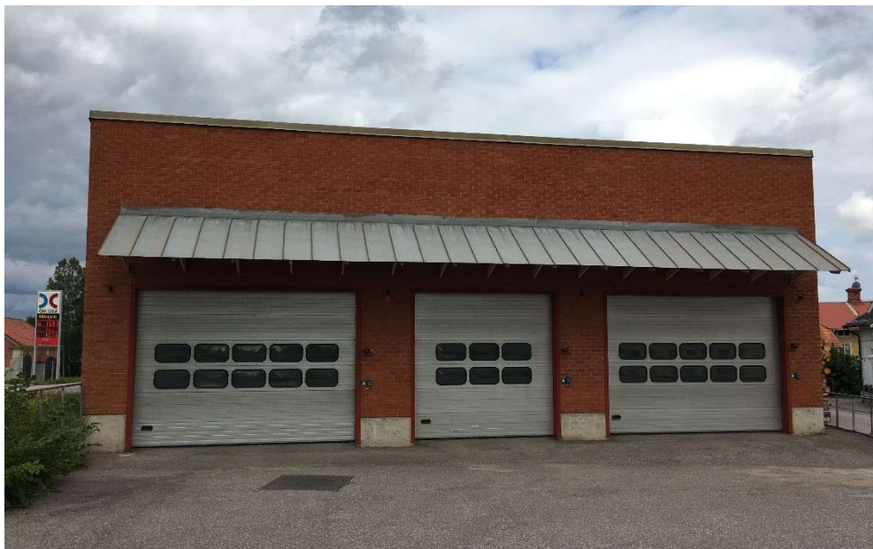
Delen av befintlig byggnad som kommer användas som deltidsbrandstation.
